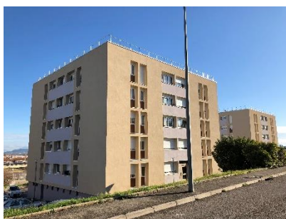
« La Rochette » à BOURG SAINT ANDEOL 114 logements
